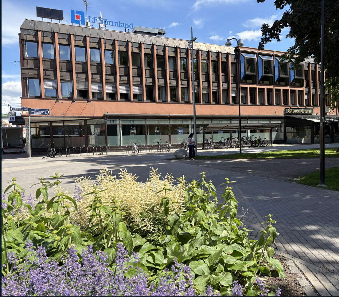
Ongoing tenant adaptation for Länsförsäkringar, 2 600 sq.m in Nyköping
