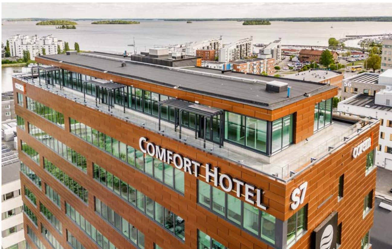
Fastigheten S7 (Sigurd 7) i Västerås med Västerås central som närmsta granne och Mälarens strand i blickfånget. Certifiering pågår med målet BREEAM In-Use, Very good.
