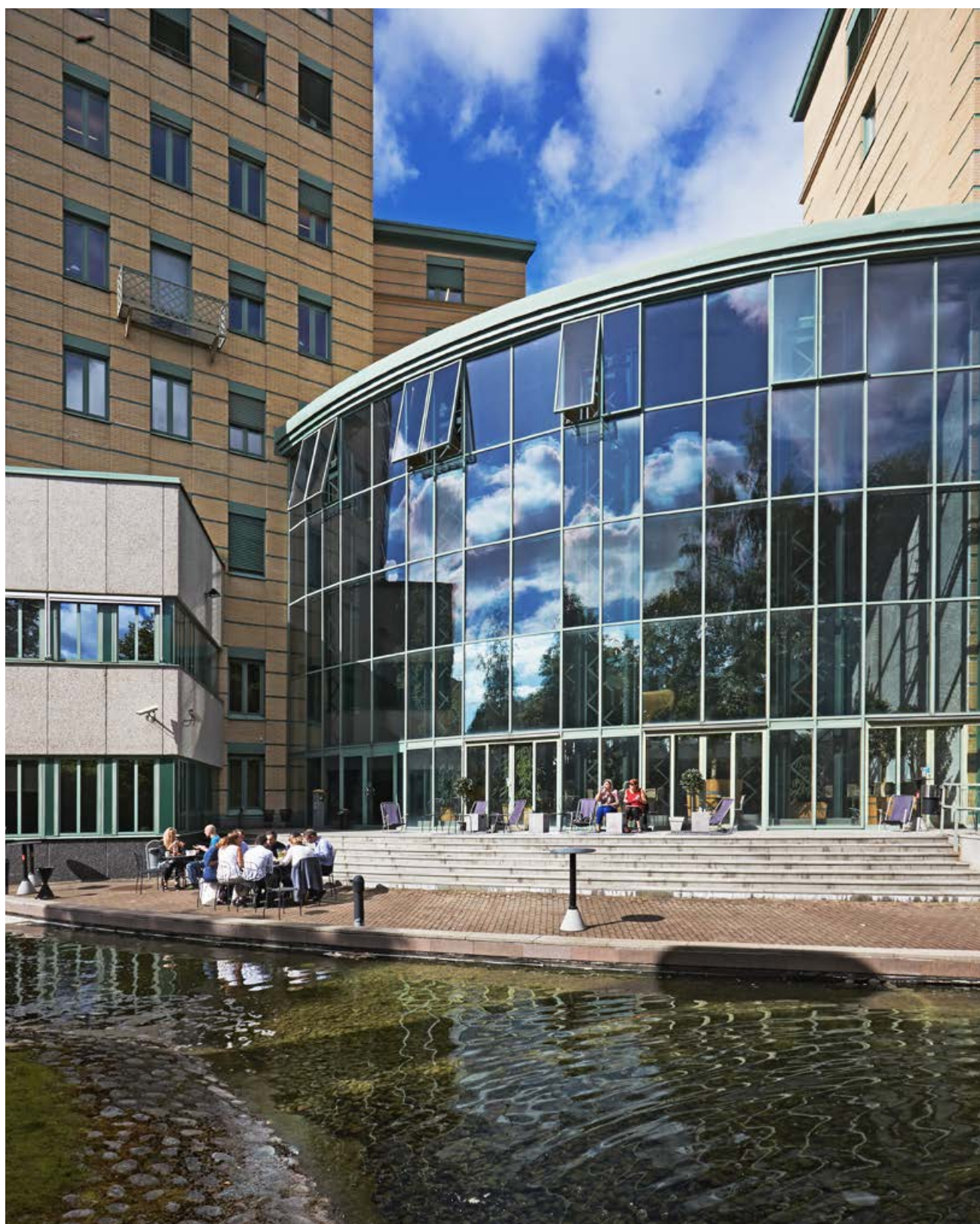
Hyresgäster i Solna Gate, fastigheten Aprikosen 2. Här erbjuder Corem konceptet Corem Meetings med konferensrum och kringtjänster. Solna Gate är även certifierad enligt BREEAM In-Use, nivå Very Good.
