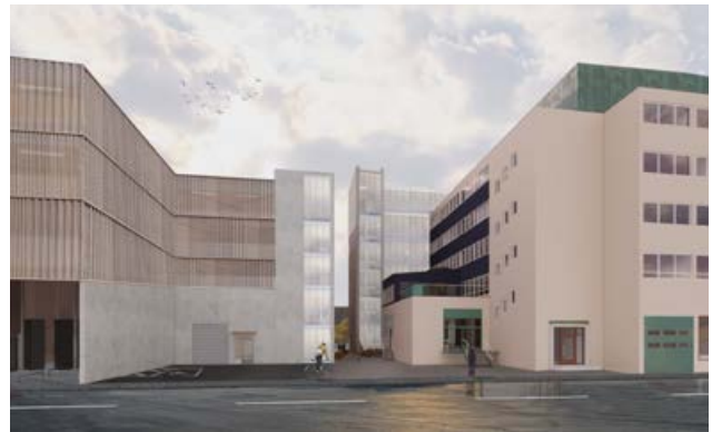
Nattskiftet 12 och 14. Nybyggnation av parkeringshus och ombyggnation av kontorslokaler i Västberga i södra Stockholm.
