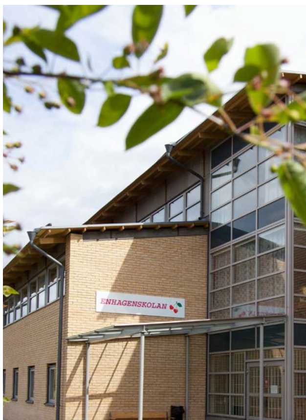
Fastigheten Svänghjulet 1 är en av Corems fastigheter som energioptimeras med hjälp av AI-teknik.
